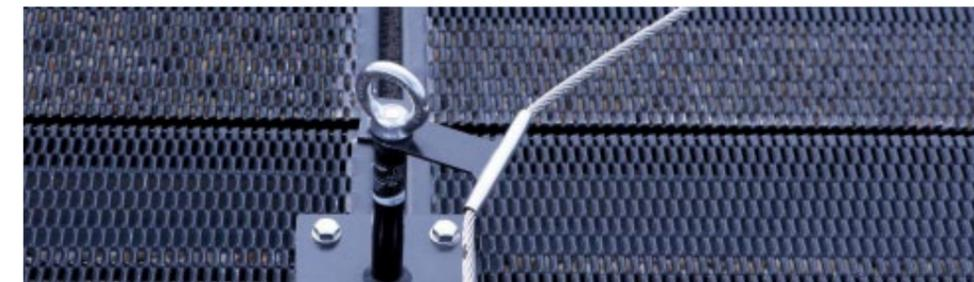
ten bewertet und erlauben den Handwerkern, diese Tätigkeiten mit Einsatz von Persönlicher Schutzausrüstung gegen Absturz (PSAgA) auszuführen. In diesem Fall dienen geeignete Sicherheitsdachhaken oder Anschlagvorrichtungen der Befestigung der PSAgA.
